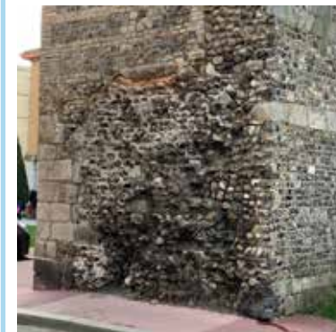
Mur attenant à la porte des Tourelles
